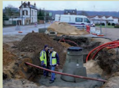
A noter : une cuve enterrée de 10 000 litres a été mise en place afin de récupérer les eaux pluviales qui alimenteront la fontaine ainsi que le dispositif d'arrosage automatique des espaces verts de l'esplanade.
