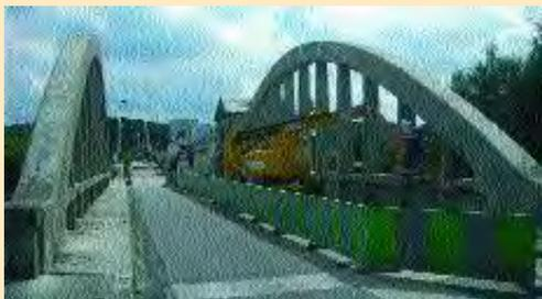
En plus de l'entretien annuel et d'un "grand nettoyage", le pont suspendu, construit en 1953, a fait l'objet d'interventions lourdes avec le changement des joints de dilatation et l'équilibrage de l'ensemble des suspentes. Ces travaux ont été menés par la Direction Départementale des Routes de Seine-Maritime.
